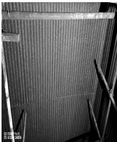
图1 炉膛水冷壁管道
